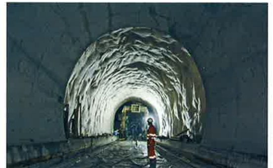
Innenausbau des Lötschbergtunnels
